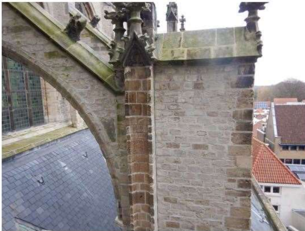
Overzicht van het (nieuwe) voegwerk aan de contrafort en luchtboog
